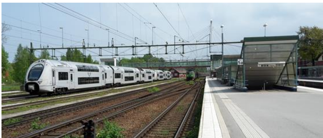
Figur 16: Hallsbergs personbangård med uppställningsspår (t v) och perrongspår GGB (t h). På förbigångsspåret norr om detta är ett godståg på väg in.
