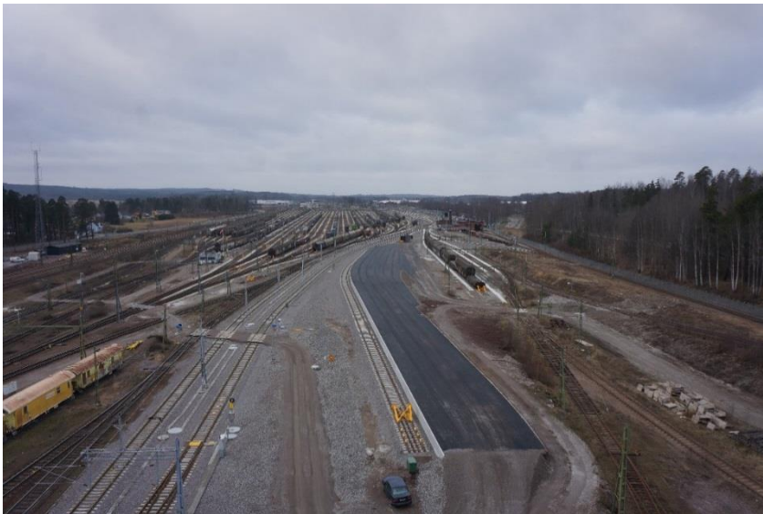
Figur 68: Befintlig "renoverad" lastplats för makadam.
